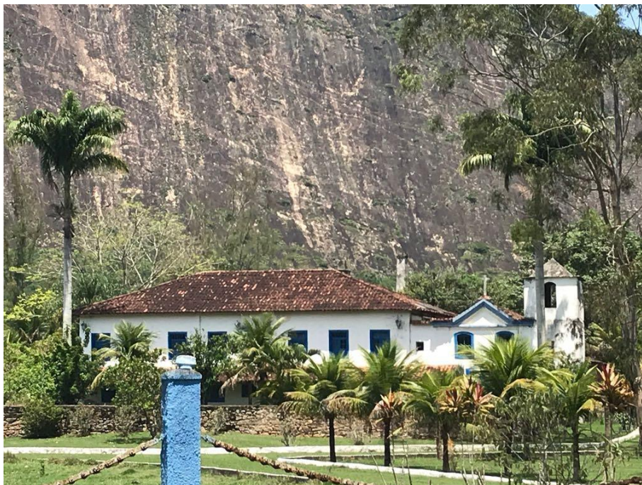
Início da rota Caminho de Anchieta
